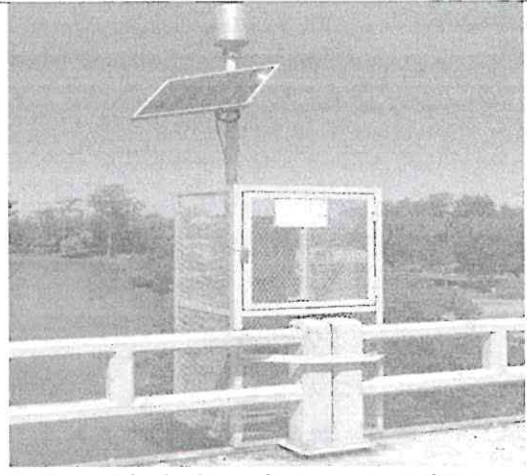
Estación hidrométrica automática
